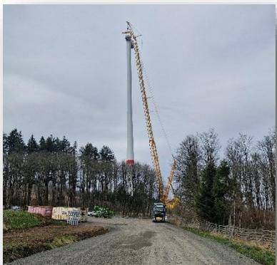
Nach Ablauf der Betriebsdauer erfolgt der Rückbau der Windkraftanlage unter Einhaltung aller umweltrechtlichen Vorgaben. Die Anlage wird systematisch demontiert, verbaute Materialien fachgerecht getrennt und überwiegend recycelt. Fundamente werden – je nach Standort – vollständig oder teilweise entfernt, die Fläche weitgehend in ihren Ursprungszustand zurückversetzt. Ziel ist ein
