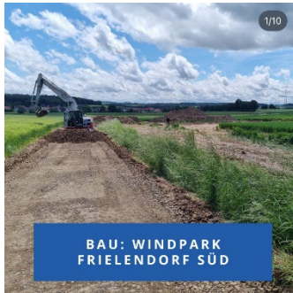
Bau Windpark Frielendorf Süd, Jul. 23
